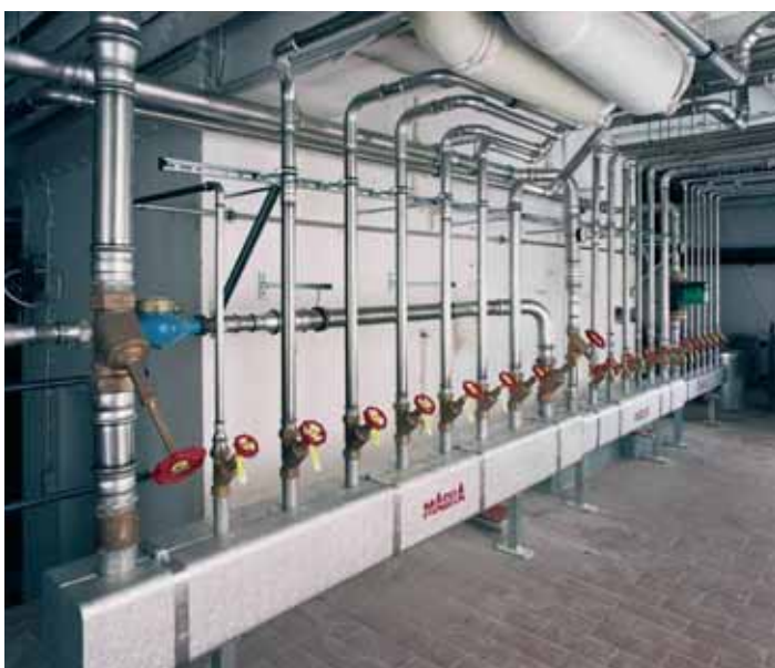
▶ MAGRA-Edelstahl-Verteiler mit MAGRA-Fertigisolierung
