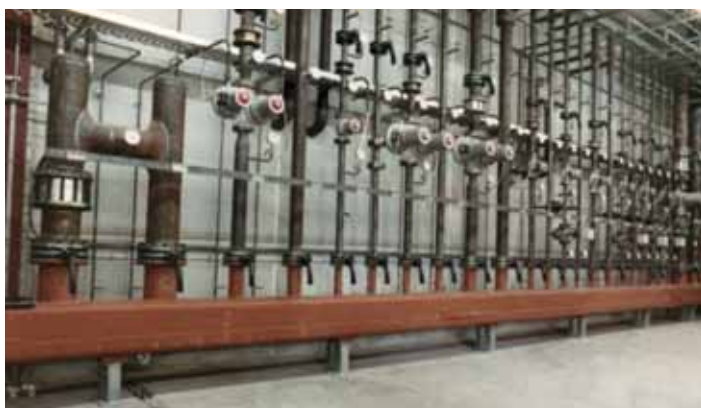
▲ Heizungsverteiler mit Vor- und Rücklaufabgängen übersichtlich nebeneinander
